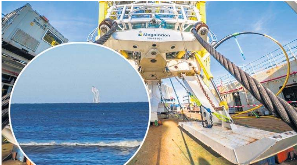
Wzdłuż naszego wybrzeża powstaje korytarz kablów dla morskiej farmy wiatrowej Baltica 2. Zakończył się pierwszy etap przygotowania dna Bałtyku pod układanie kabli
