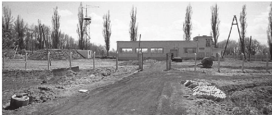
Budowa biurowca zamojskich wodociągów. Potem założono tutaj Środowiskowy Dom Samopomocy Społecznej. Zdjęcie z 1960 roku. Fot. APZ
