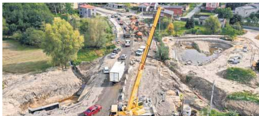
Rozbudowa drogi krajowej nr 94 pomiędzy Pyskowicami a Zabrzem. Wieszowa, ul. Mickiewicza – budowa przepustu i zbiornika retencyjnego
