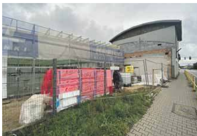
Konstrukcja budynku jest gotowa
