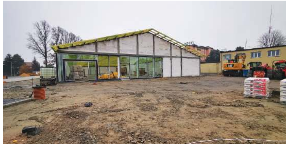
Trwa budowa w okolicy ronda przy ul. Warszawskiej
