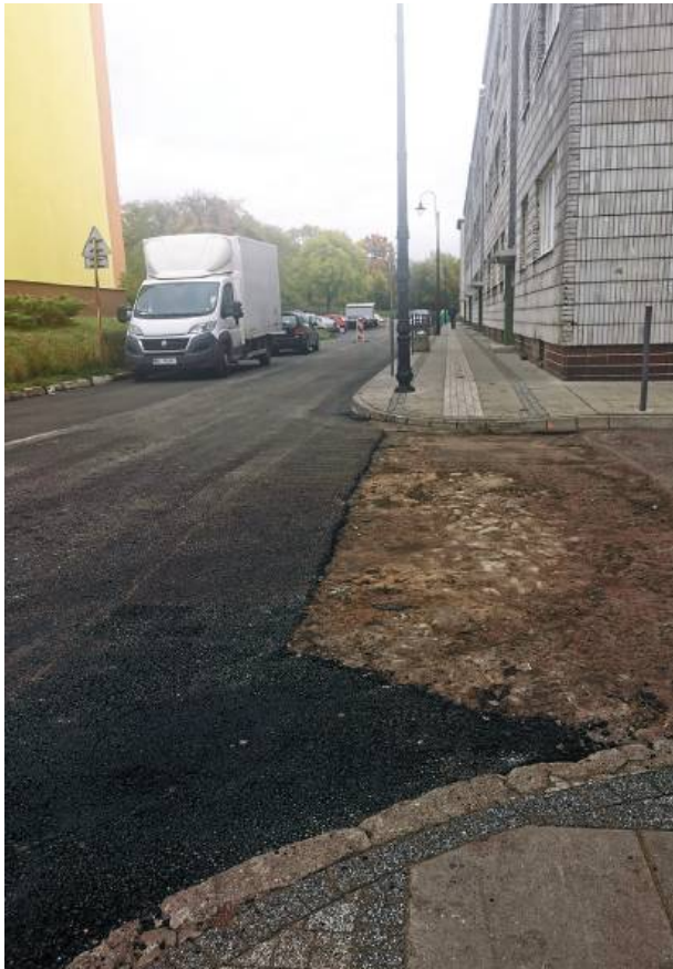
Wymiana nawierzchni ul. Mickiewicza w rejonie „białych bloków”
