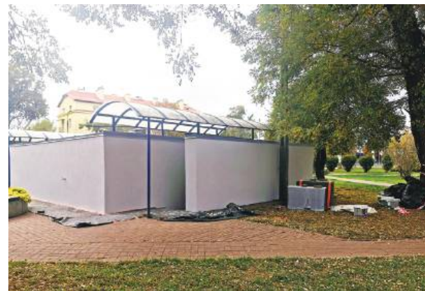
Trwają prace remontowe związane z wymianą elewacji szaletu miejskiego
