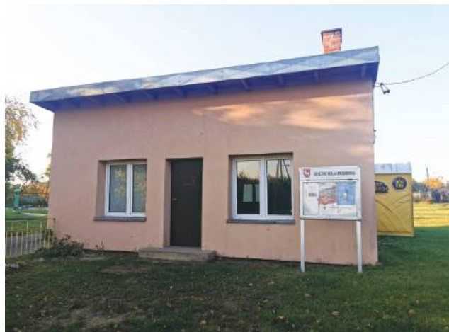
Budynek świetlicy wiejskiej w Wólce Smoszewskiej będzie remontowany
