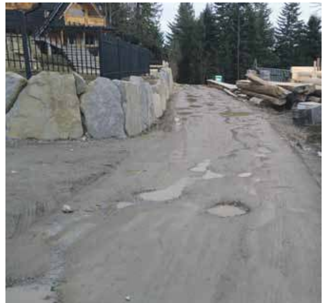
Droga grozy Pod Blachówką będzie wyremontowana do jesieni.
