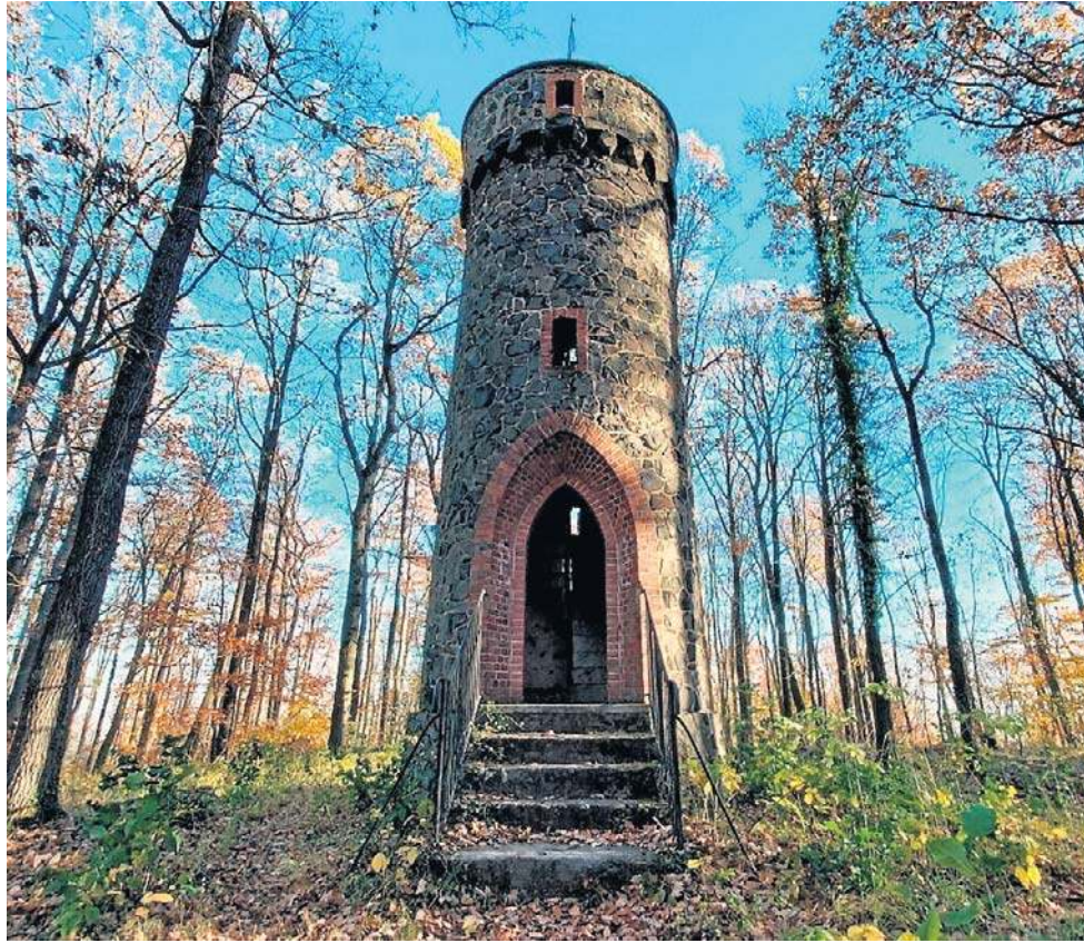
Wieżę wybudowano w 1906 r., prawdopodobnie z inicjatywy Towarzystwa Karkonoskiego
