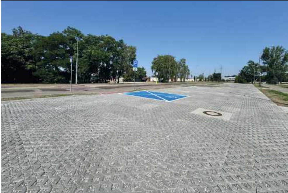
Koniec prac przy Jagiellończyka. Nowy parking gotowy!
