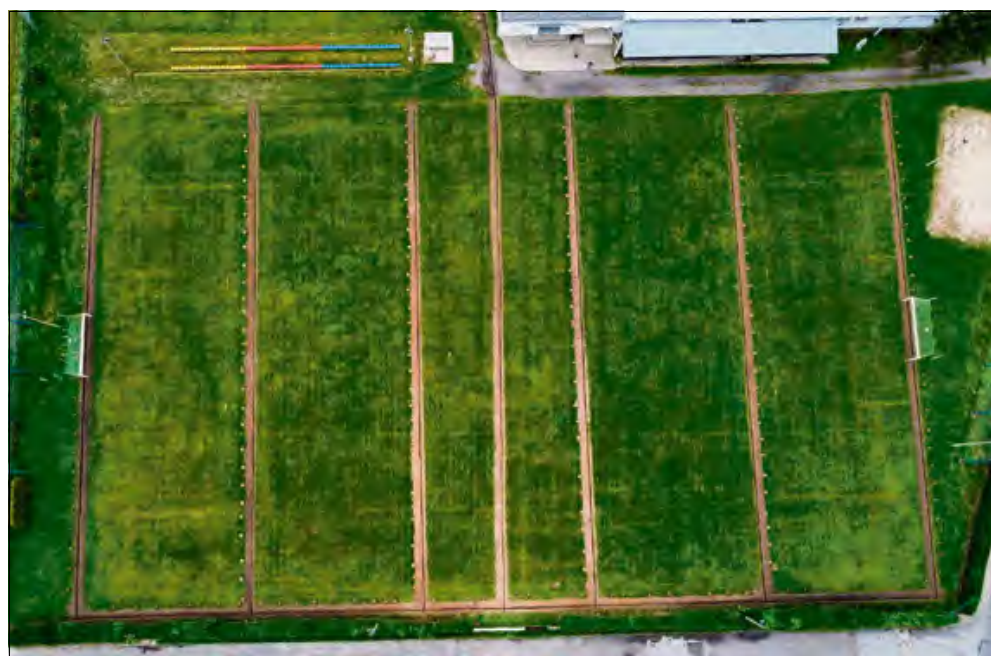
Prace instalacyjne wymagały wielu przygotowań.
