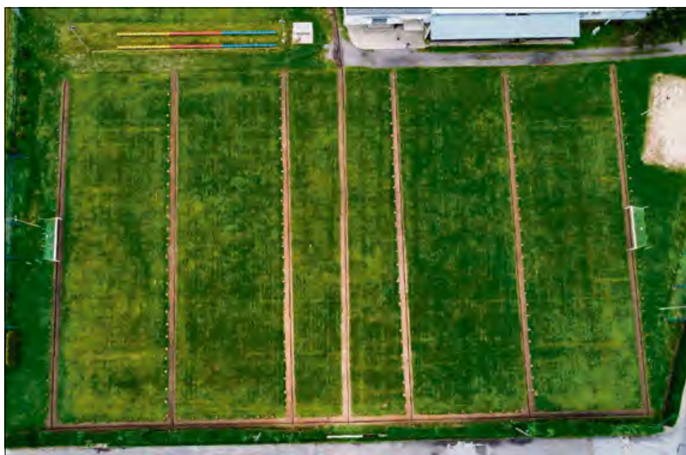
Prace instalacyjne wymagały wielu przygotowań.
