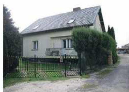
Widok budynku mieszkalnego od strony północno-zachodniej.
