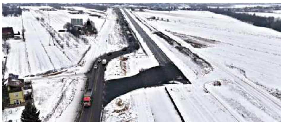
Odcinek drogi ekspresowej S19 Lubartów–Lublin nabiera coraz wyraźniejszych kształtów
