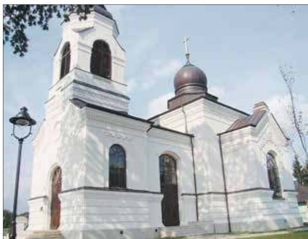
W latach 2007-2018 w cerkwi przeprowadzono szereg prac renowacyjnych. Uchroniły ją one przed całkowitą ruiną i przywróciły pierwotny blask
