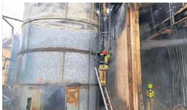
Pożar silosu na terenie zakładu drzewnego w miejscowości Gracuch pod Końskimi.
