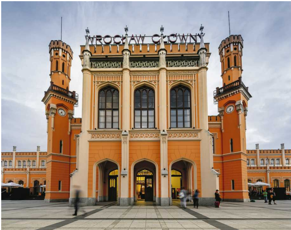
Dworzec PKP Wrocław Główny
