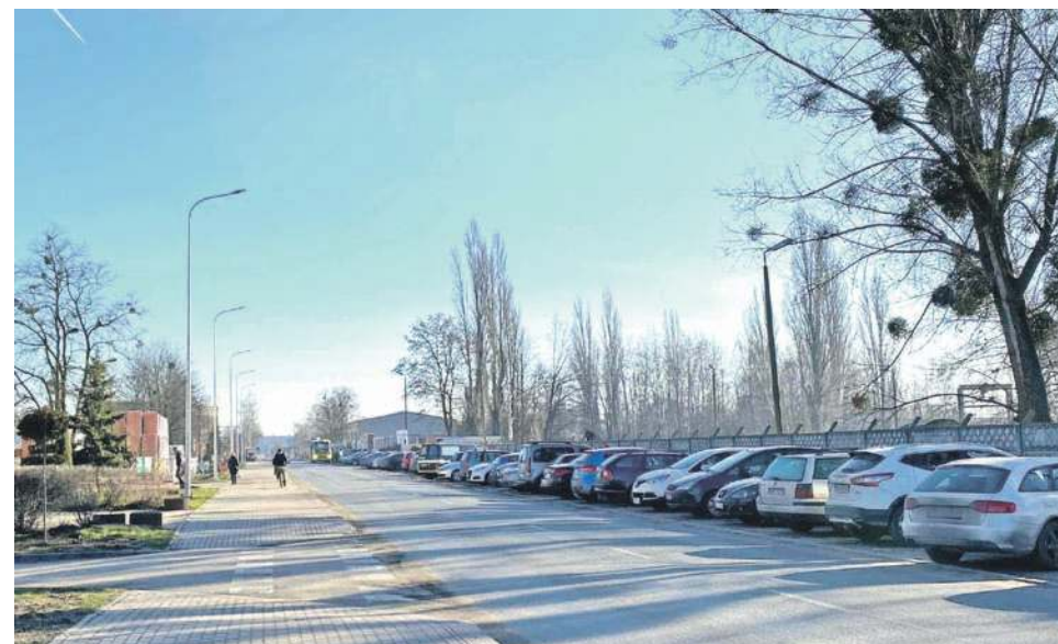
Na ulicy Ofiar Katynia trwa montaż oświetlenia drogowego. Inwestycja prowadzona jest wspólnie przez Urząd Miejski i Starostwo Powiatowe.
