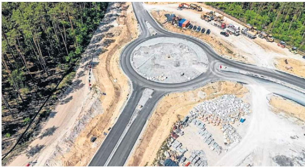
Budowa drogi S10 w Kujawsko-Pomorskiem - stan w czerwcu 2026
