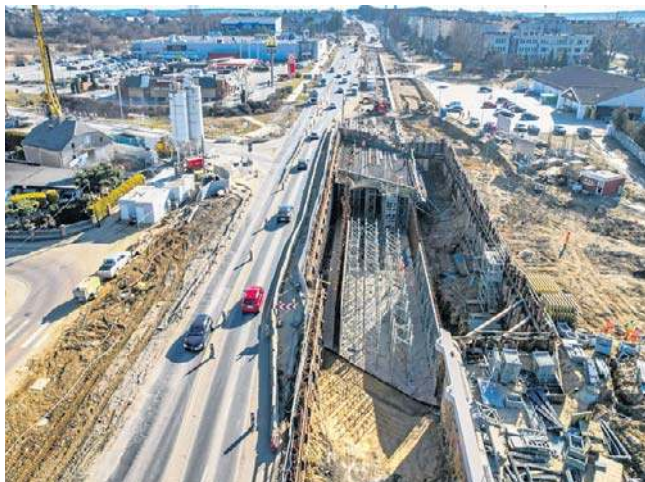
Tak dziś wygląda przebudowa odcinka DK94 w Olkuszu. Koniec inwestycji jest planowany na 2027 rok
