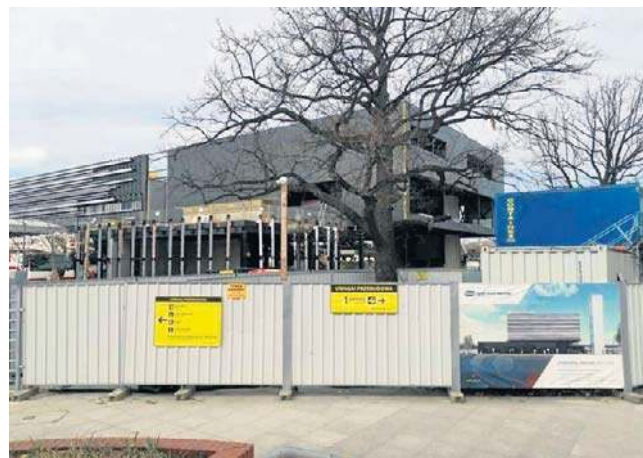
Zakończenie całej inwestycji planowane jest na koniec 2027 roku
