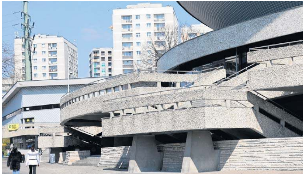
Samorząd chciał tarasy Spodka wyburzyć i odbudować, ale interweniował konserwator
