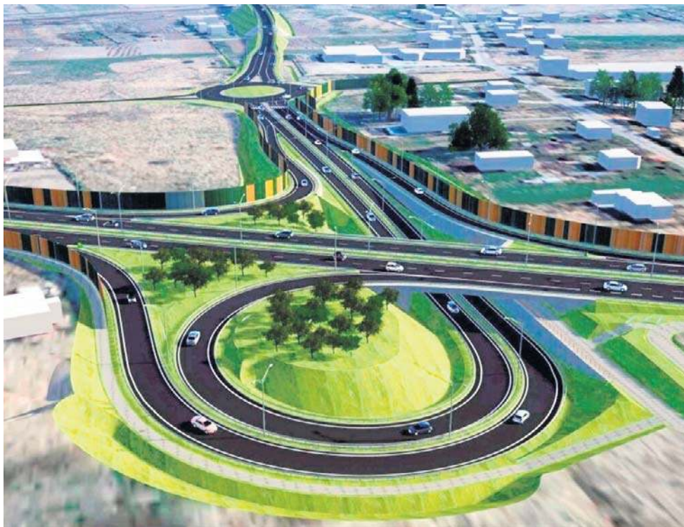
Budowa obwodnicy miałaby wyprowadzić ruch tranzytowy poza ścisłą zabudowę i uporządkować lokalny układ komunikacyjny
