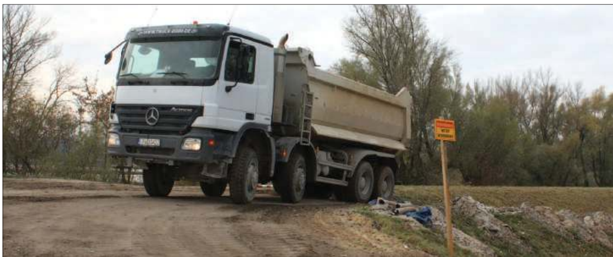
Na drodze prowadzącej do wału widać dowożące towar samochody ciężarowe oraz inne maszyny. Prace idą pełną parą
