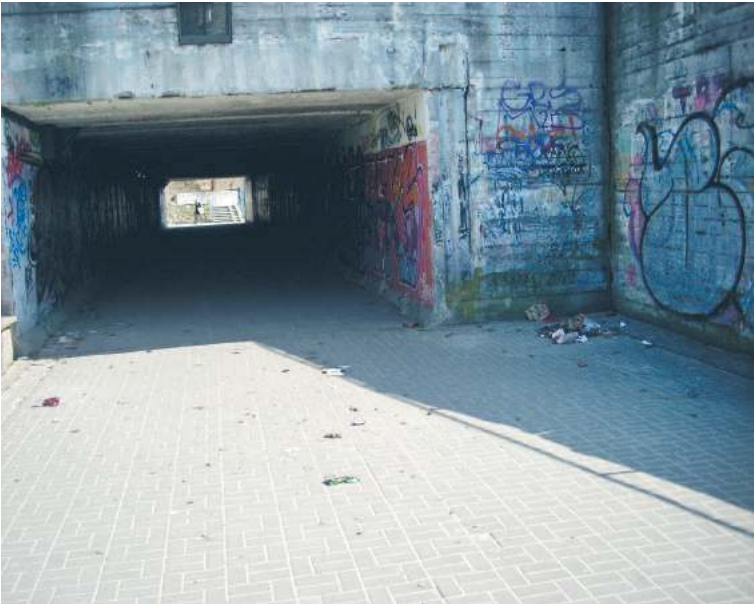
Jako jedno z najniebezpieczniejszych miejsc na osiedlu mieszkańcy wskazali tunel pod ul. Armii Krajowej, gdzie często spotykają się chuligani
