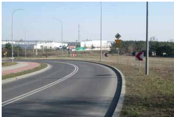
Zjazd z wiaduktu północnego do ul. Gdyńskiej. Tutaj ma mieć początek nowa obwodnica
