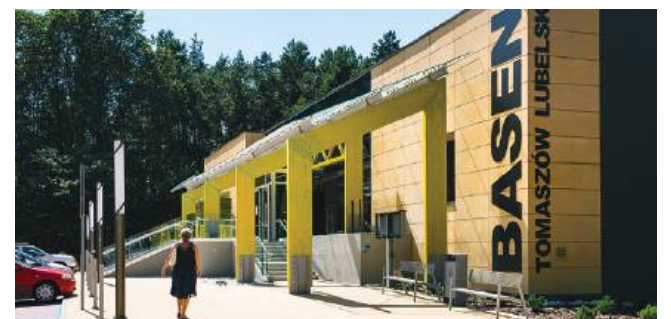
Modernizacja kompleksu sportowego OSIR Tomasovia
