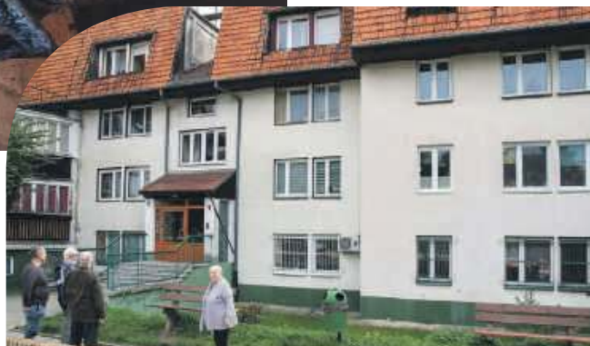
Elewacja od podwórka
