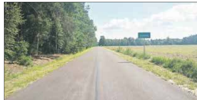
Na końcowy odbiór czeka przebudowa drogi nr 1072L na trasie Łomazy – Kolembrody – Wiski wraz z remontem trasy powiatowej nr 1105L Rossosz – Kozły. Jej łączna długość to ponad 14 km
