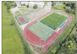
Inwestycja przy Zespole Placówek Oświatowych w Piszczacu jest już na finiszu
