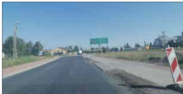
Niebawem ukończona zostanie przebudowa i rozbudowa drogi nr 1051L Zalesie – Piszczac – Sławatycze, a konkretnie odcinka od krajowej drogi do granicy gminy Zalesie o długości prawie 2,5 km
