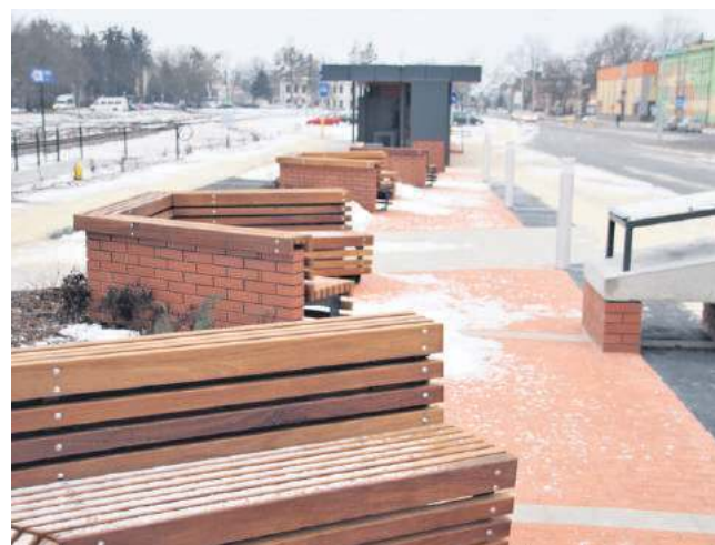
W nowym węźle komunikacyjnym przy ul. Peowiaków miejsca nie brakuje. Są też ławki dla podróżnych.
