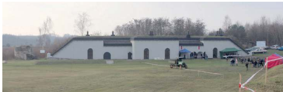
Prawie rok trwały prace nad odnowieniem obiektu
