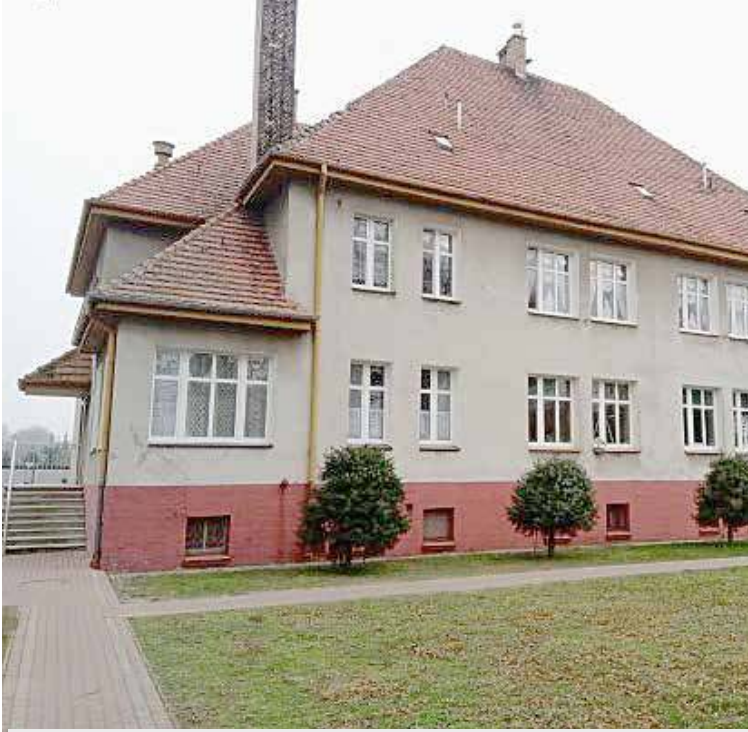
To w tym budynku podłożona miała być bomba, na szczęście był to tylko kiepski żart. fot. Gmina Maszewo
