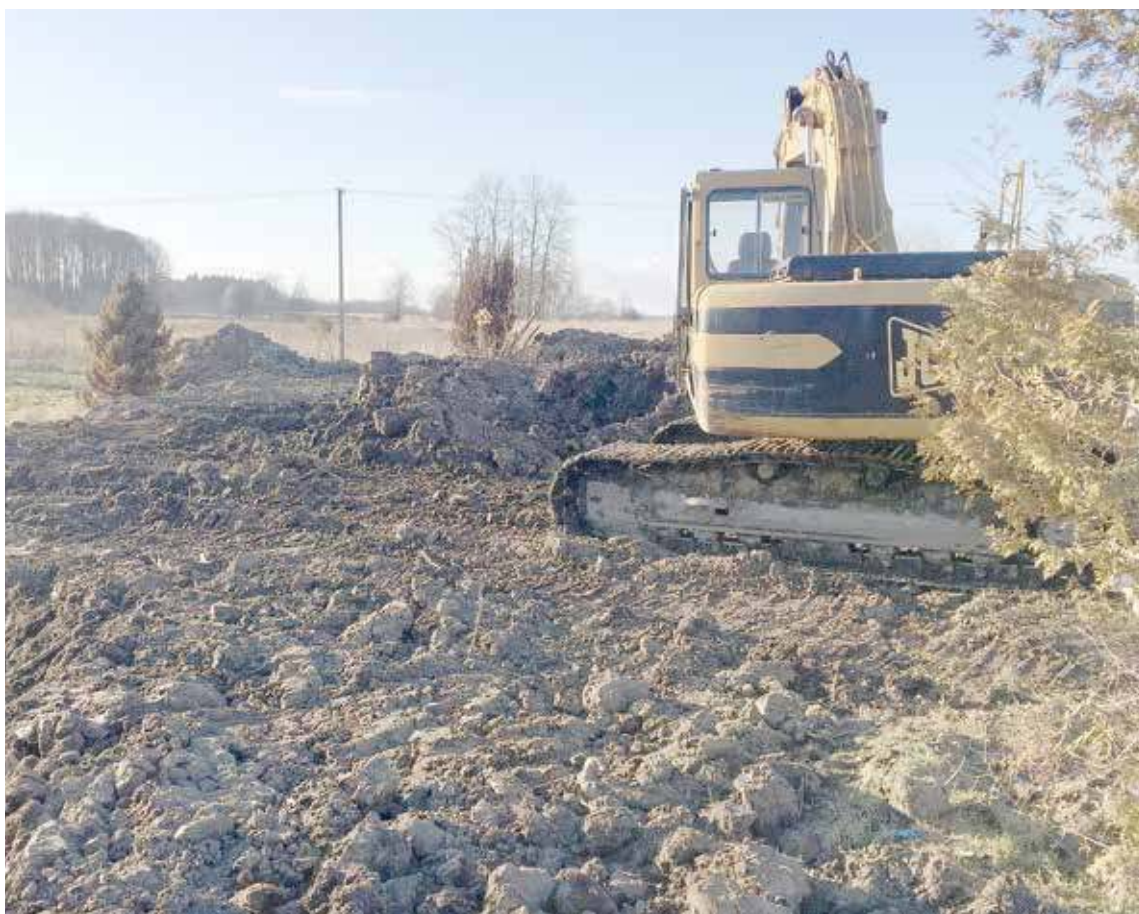
Prawidłowo wykonane prace ziemne są podstawą założenia dobrze funkcjonującego ogrodu
