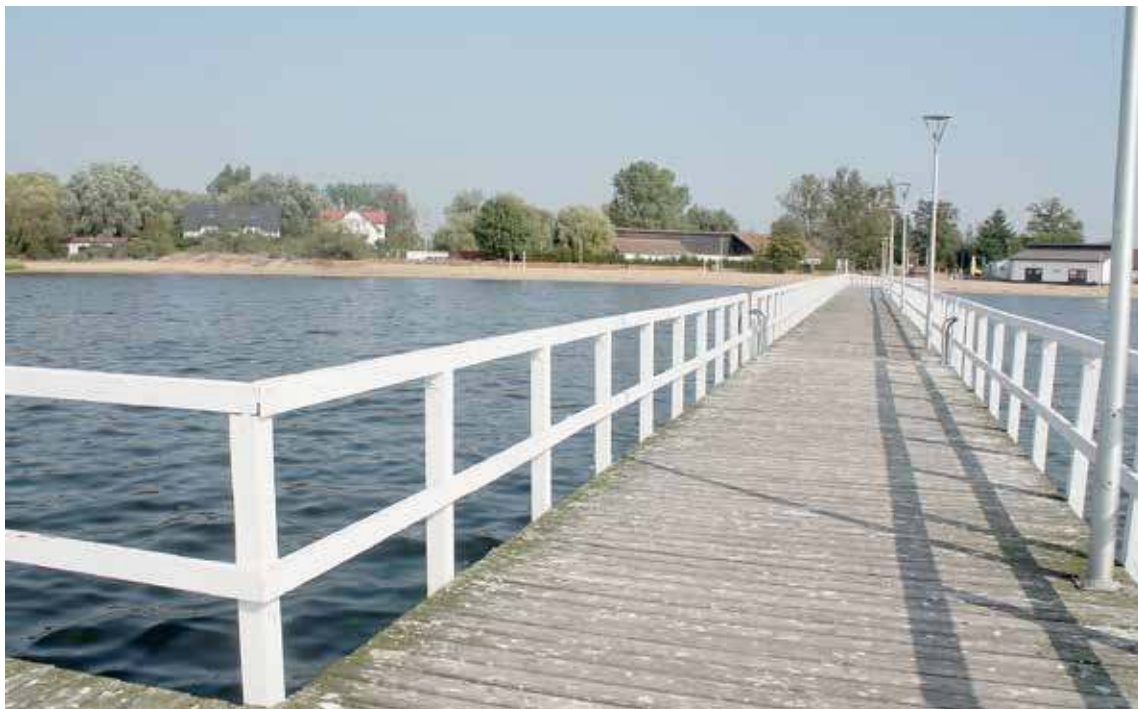
I w przyszłorocznym budżecie nie zabraknie inwestycji w poprawę infrastruktury turystycznej, w tym dalszego remontu moła. Wszak Stepnica nie tylko w sezonie to prawdziwy kurort
