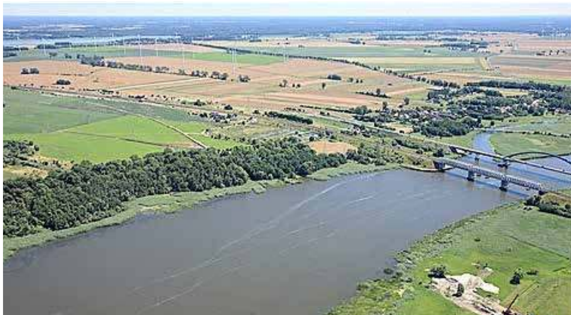
Jeden z etapów budowy gazociągu zakładał przewiert pod rzeką
