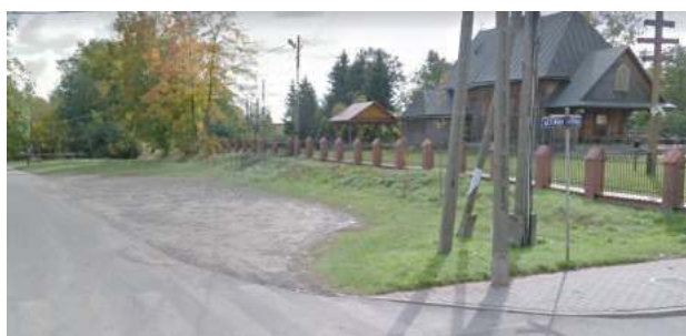
Parking przy kościele św. Rocha przed remontem DW835
