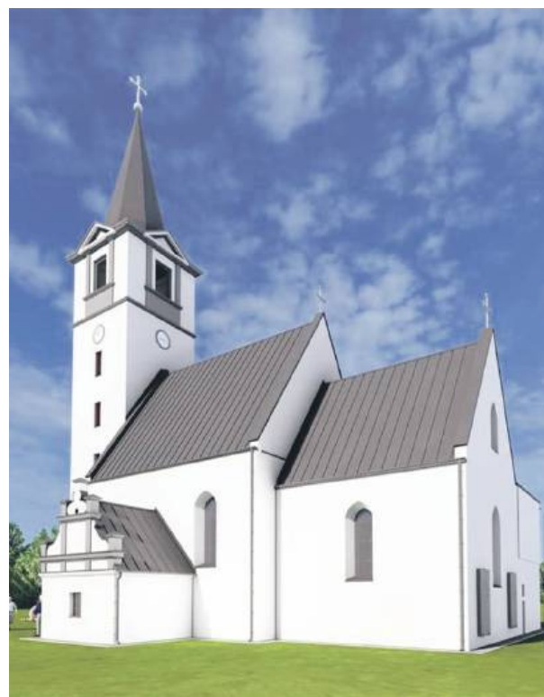
Tak będzie wyglądał kościół w Zielenicach po zakończeniu wszystkich trzech etapów prac remontowych
