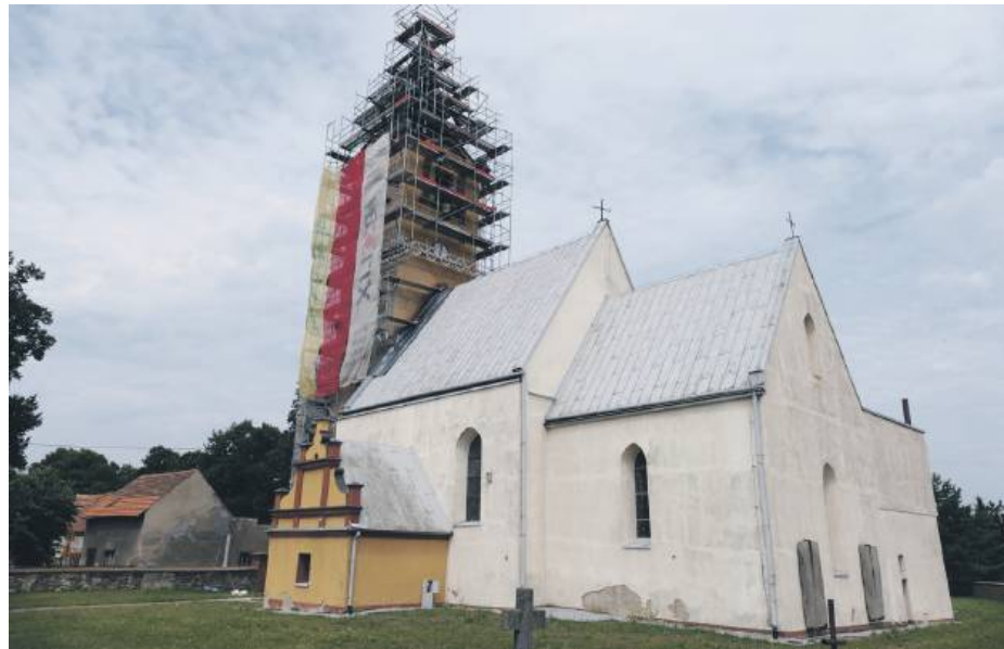
Obecnie trwają prace przy remoncie wieży kościoła parafialnego w Zielenicach
