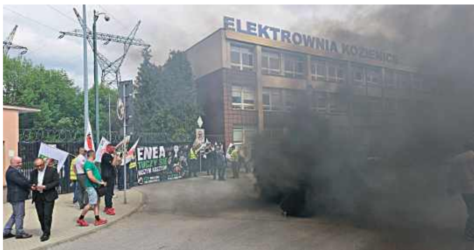
Gorąca atmosfera przed Elektrownią Kozienice
