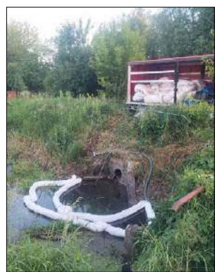
Pewna ilość substancji ropopochodnych dostała się do kanalizacji deszczowej oraz do kanalizacji sanitarnej
