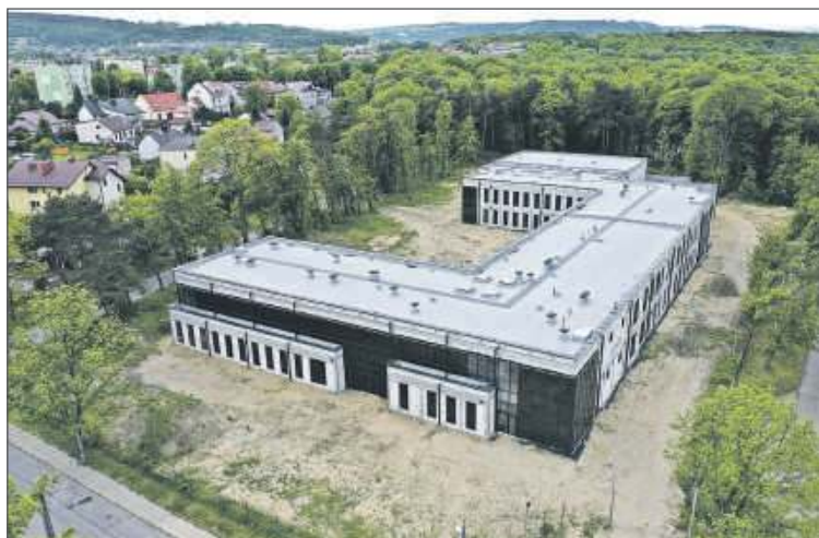
INWESTYCJA ROKU - budowa nowej siedziby Zespołu Szkół Specjalnych to obecnie największa inwestycja w naszym powiecie.
