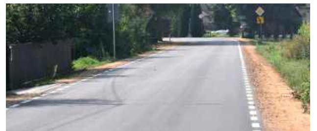
Nowa jakość podróży - droga już odebrana
