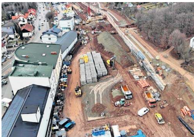
Tak obecnie wygląda teren przy stacji Limanowa. Wkrótce pojadą tędy pociągi
