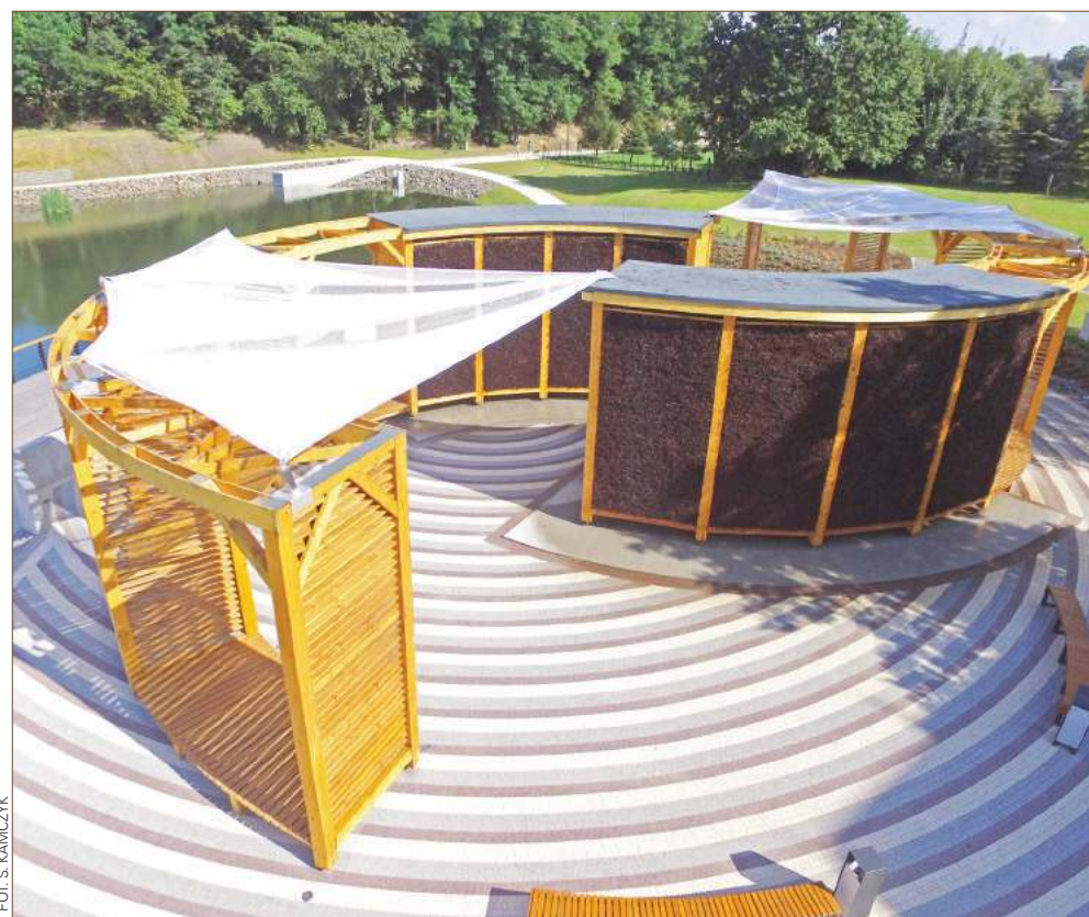
Po gałkach tężni już spływa solanka. Po testowym rozruchu obiektu tężnia pozostała włączona, aby miasto nie musiało ponosić dodatkowych kosztów.
