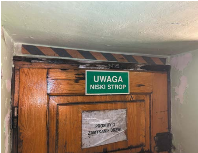
FOT. 1 Nieprawidłowo ocieplone (przemarzające) drewniane drzwi zewnętrzne zaatakowane przez grzyba w wyniku zawilgocenia powstałego na skutek kondensacji pary wodnej; fot.: autor
