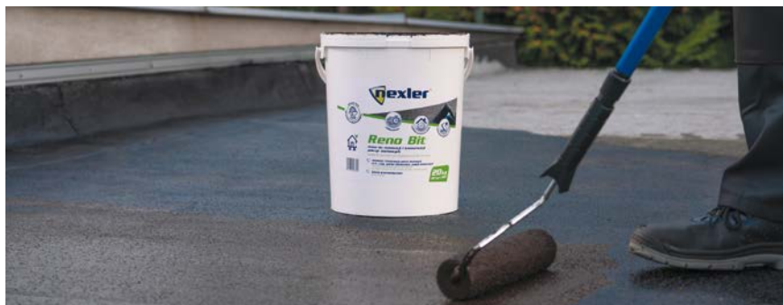
FOT. 1 W wielu przypadkach wystarczy renowacja powłokowa
