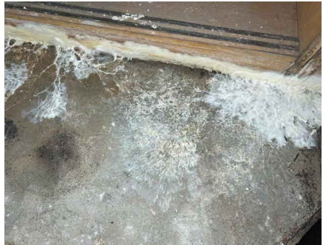
FOT. 2 Grzyb domowy rozwinął się w zawilgoconej piwnicy, w której przechowywano drewniany regał; fot.: autor
