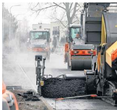
Ul. Pod Skarpą została przebudowana w 2024 roku
