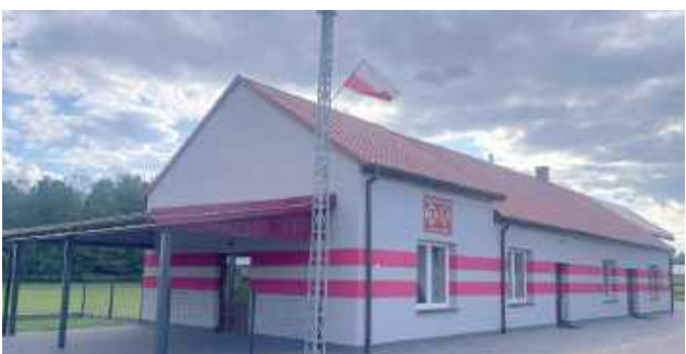
mo Modernizacja strażnicy w Gołych Łazach
