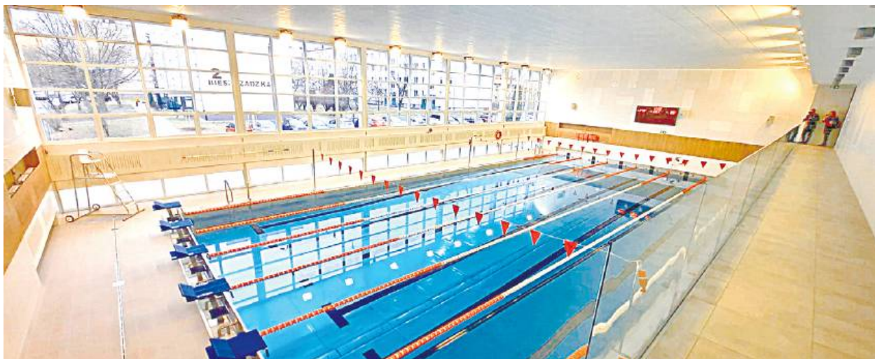
Pływalnia przy siedleckiej „Ósemce” już jest po gruntownym remoncie. Prace modernizacyjne trwały półtora roku, ale dzięki kompleksowej przebudowie powstał nowy i nowoczesny obiekt
