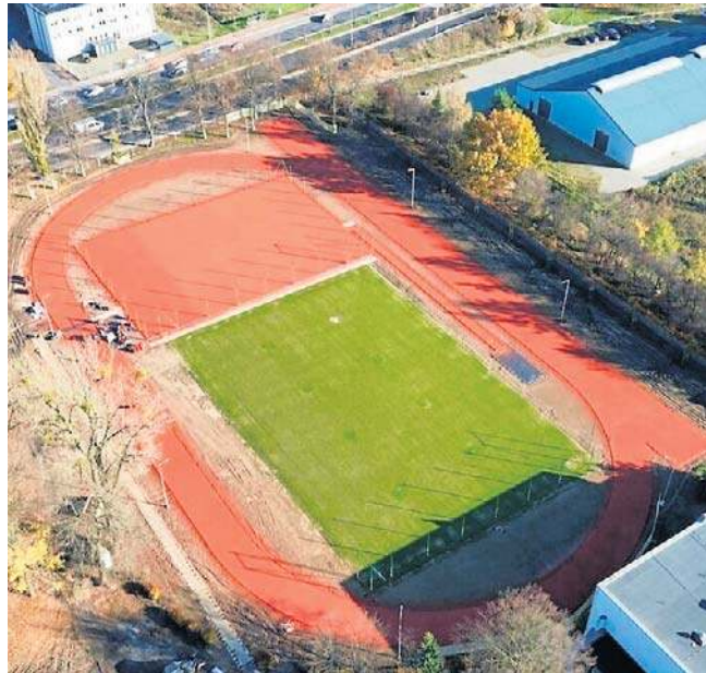
Na realizację prac wykonawca ma czas do końca roku. Koszt inwestycji to prawie trzy miliony złotych
