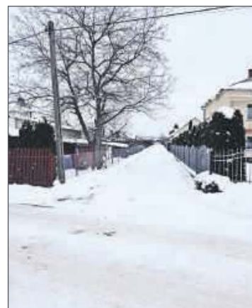
Jedna z dróg do przebudowy.
