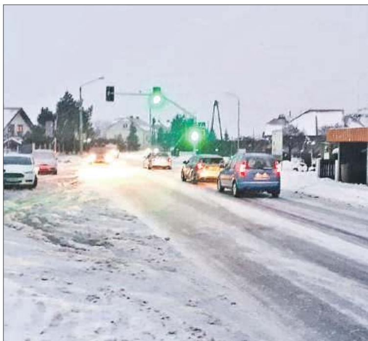
W sobotę ciężkie warunki do jazdy panowały nawet na drogach powiatowych. Na zdjęciu Straszecin.
