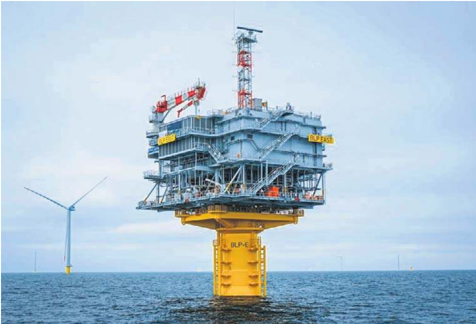
Jedna z dwóch stacji elektroenergetycznych zainstalowanych na Baltic Power
