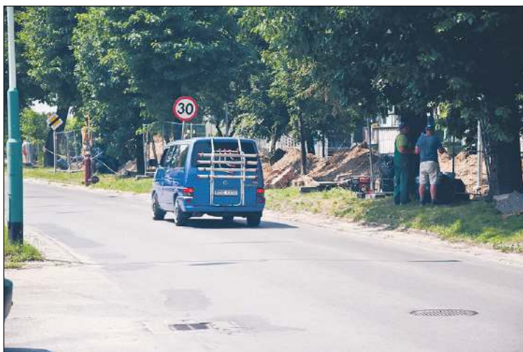
Trwają prace przy wymianie rurociągu MPEC.
