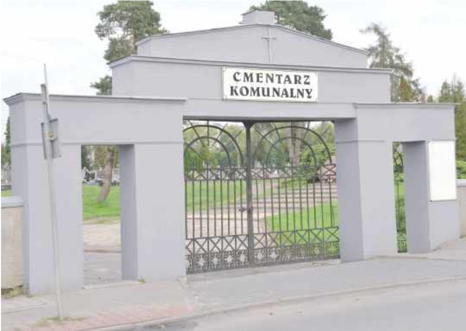
Rozpoczęto modernizację Cmentarza Komunalnego. To jedna z najważniejszych inwestycji miejskich ostatnich lat, której celem jest nie tylko poprawa funkcjonalności i estetyki tego szczególnego miejsca, ale także przygotowanie go do dalszego użytkowania przez kolejne dekady
