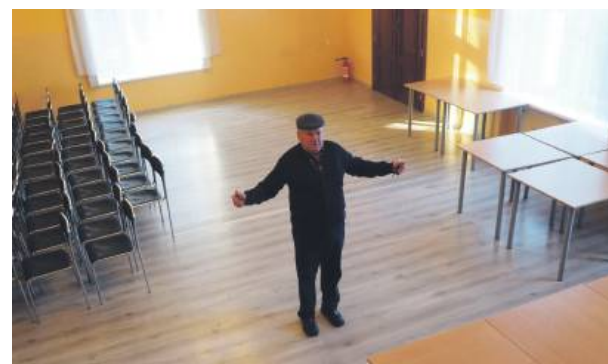
Dzięki sołtysowi wyremontowano okna, podłogi i dach świetlicy. Na remont czeka elewacja
