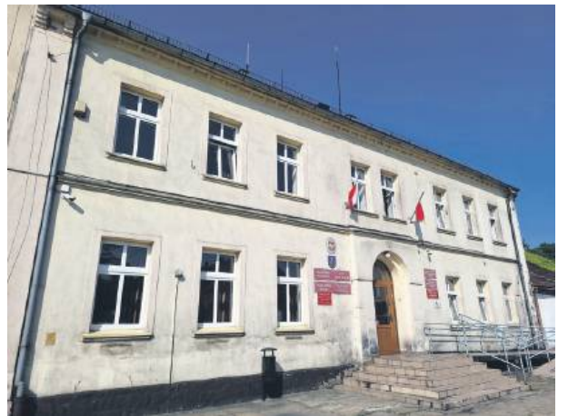
Budynek urzędu przechodzi termomodernizację
