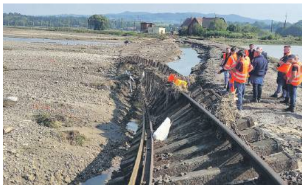
Linia kolejowa nr 309, tzw. Kudowianka, tuż po powodzi i obok linii po remoncie. Fot. Dolkom
