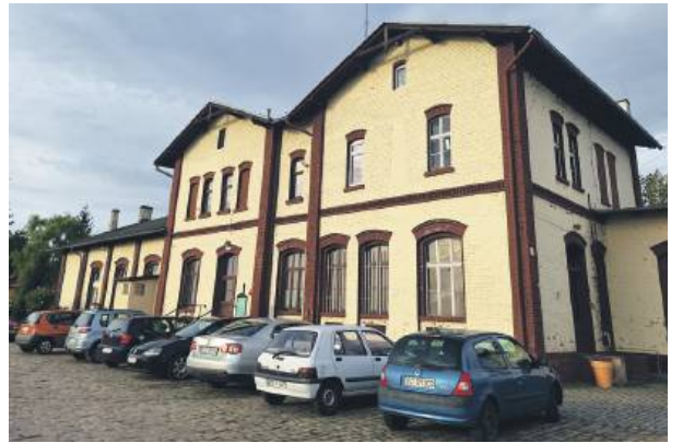
Wymieniona zostanie stolarka okienna na dworcu w Boreczku
