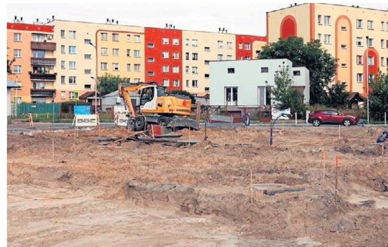
Prace budowlane na Wośnikach. W planach jest budowa nowych peronów przystankowych i chodników oraz postawienie wiat.
