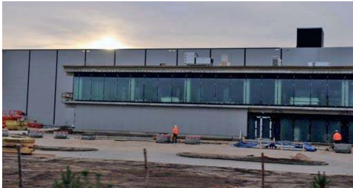
Budowa zakładu zbliża się do końca (fot. UM Nowa Sól)
