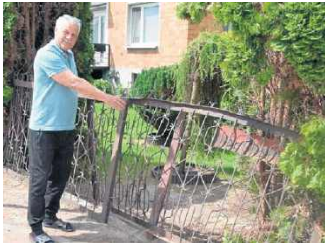
- Ogrodzenie posesji zostało kompletnie zniszczone - pokazuje Janusz Góral.
