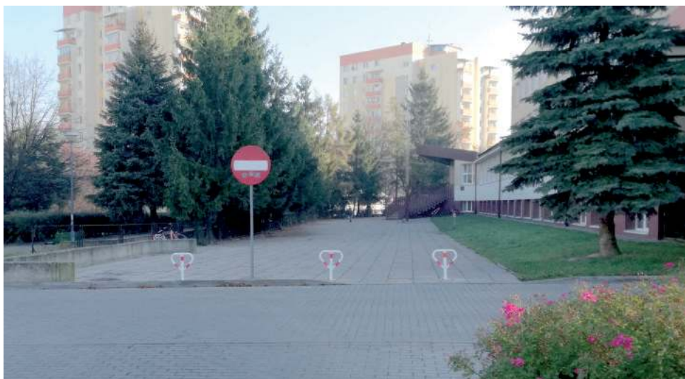
Teraz wjazd na plac bezpośredni przed budynkiem szkoły uniemożliwiają słupki
