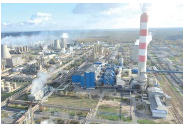
W miejscu, gdzie na pierwszym planie widać niezabudowany plac stanie nowa elektrociepłownia
