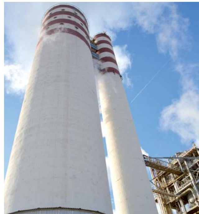
Wieże granulacyjne na wydziale mocznika naprawdę robią wrażenie. Na samą górę wjeżdża się windą, pokonując około 130 metrów
