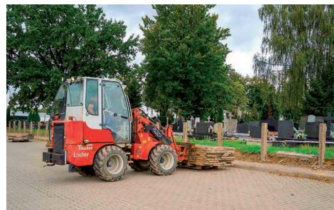
Rozbudowa ogrodzenia przy ciechanowskim cmentarzu na Gostkowie
