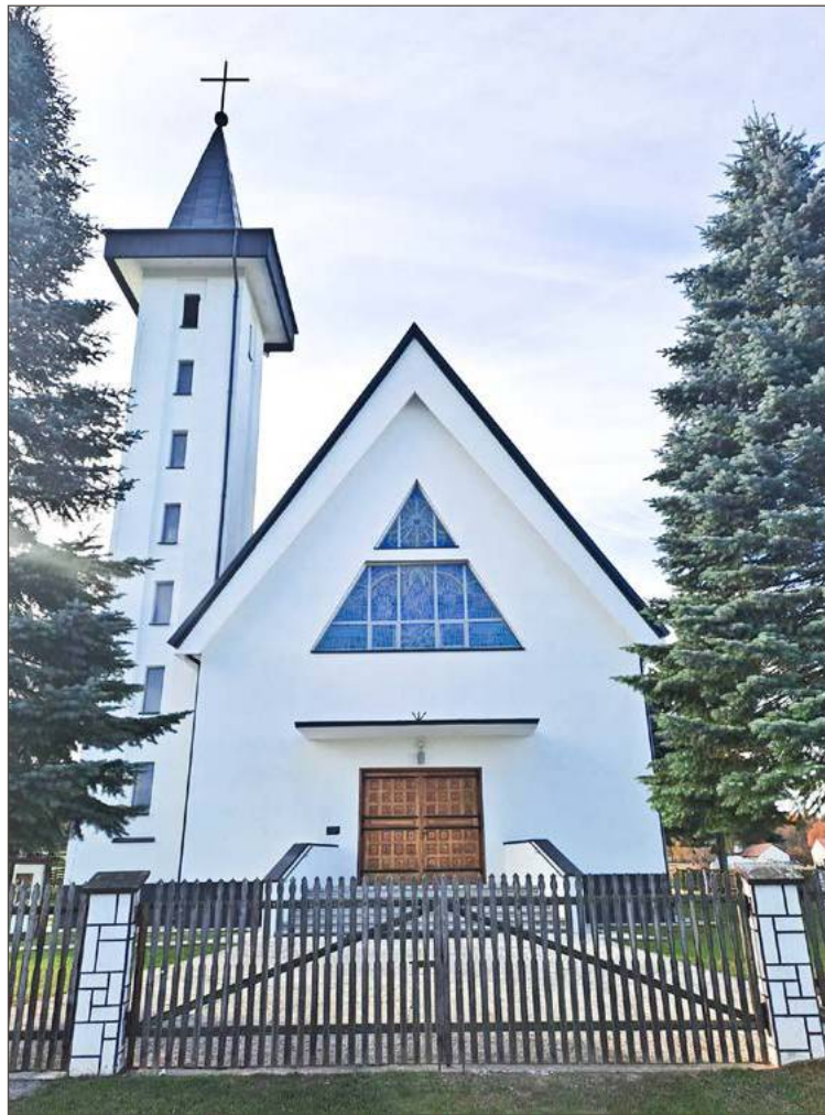
W tym roku kaplica na Wygodzie doczekała się malowania na zewnątrz.
